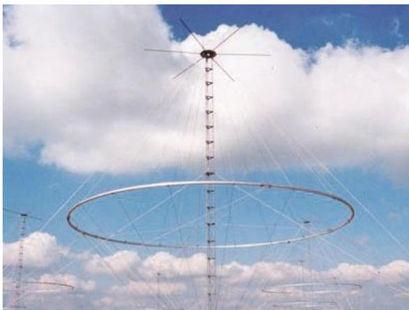
Les ondes à très basses fréquences du radar *Nostradamus* ont une portée de 1 000 km et permettent de détecter les avions furtifs conçus pour échapper aux ondes à hautes fréquences.
