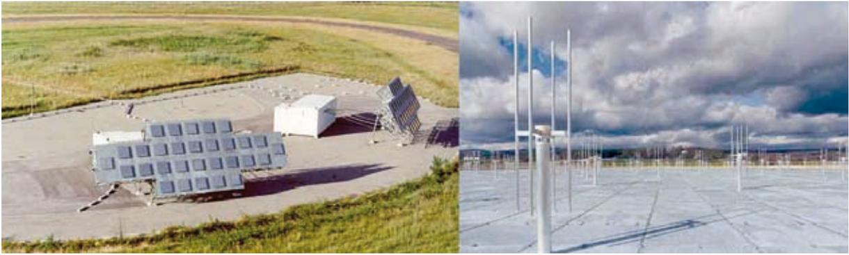
Vue d'un site d'émission du radar GRAVES (photo de gauche) et d'un site de réception (photo de droite). Le radar du système Graves a été spécifiquement conçu pour la surveillance de l'espace. C'est un système peu coûteux tant en termes de développement que de maintenance.
