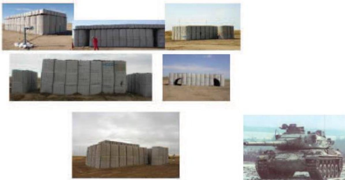
**FIG. 5.1a. – Exemples de structures renforcées. Il est important de noter que toutes les structures sont construites sur le principe de conteneurs en acier et aux parois relativement fines entourés de caisses remplies de sable ou de terre. Le char n'est inclus ici que pour représenter les véhicules renforcés.**
