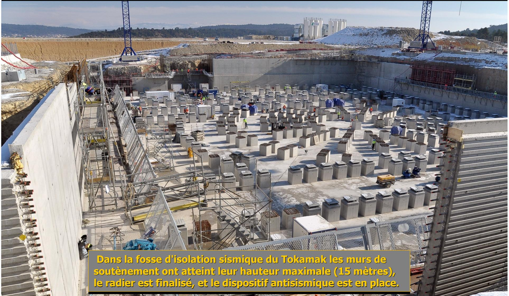
Dans la fosse d'isolation sismique du Tokamak les murs de soutènement ont atteint leur hauteur maximale (15 mètres), le radier est finalisé, et le dispositif antisismique est en place.
