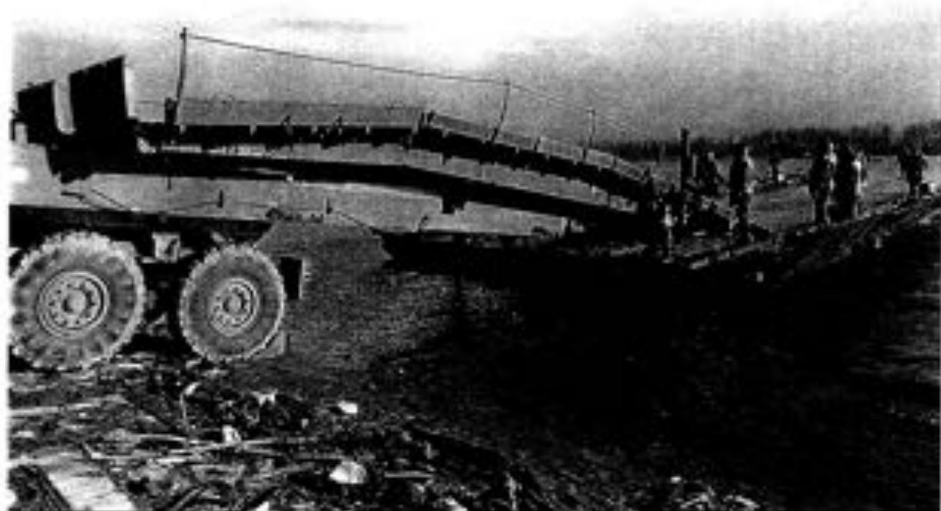
P.F.M. - Le module avec la rampe quitte la rive pour aller s'assembler à l'extrémité du pont
