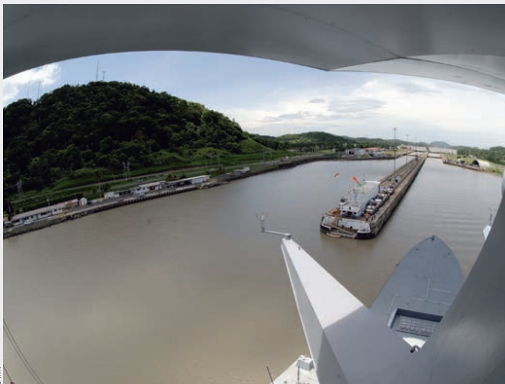
Le canal de Panama est l'un des passages maritimes les plus empruntés au monde par les navires. En 2016, il fait peau neuve. Officiellement terminés le 26 juin, les travaux d'agrandissement se sont répartis sur plusieurs chantiers impliquant de concevoir et d'édifier de nouveaux systèmes d'écluses et de nouvelles voies de navigation.
