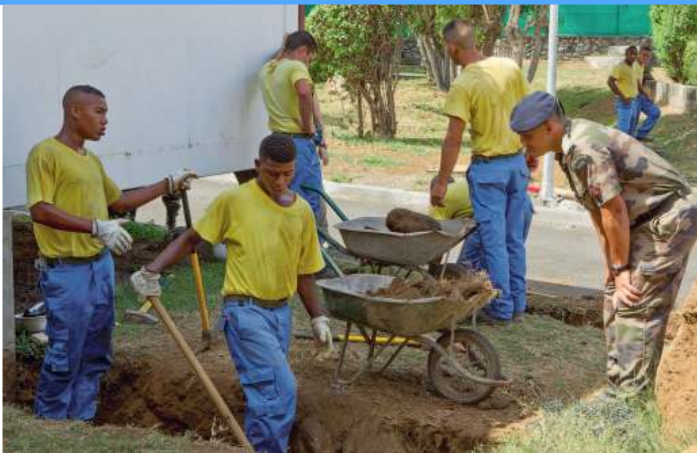
À Saint-Pierre, dans le sud de l'île de La Réunion, des stagiaires sont formés à la maçonnerie.
