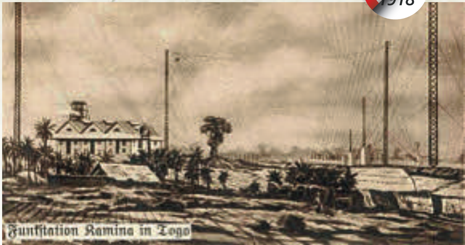
La station radio de Kamina. Avant de se rendre, les Allemands ont saboté cette installation ultramoderne afin qu'elle ne puisse être utilisée contre leurs intérêts.
