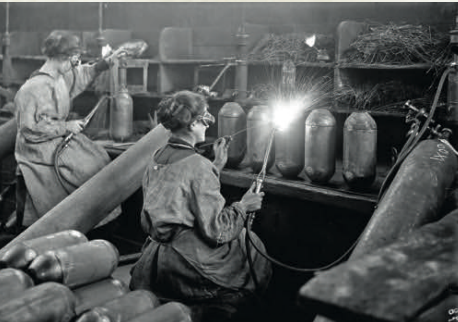
Aux forges de la Chaléassière, à Saint-Étienne, des ouvrières soudent au chalumeau le corps des torpilles qui serviront de munitions aux mortiers de tranchée 58 T.
