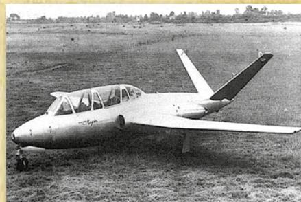
Le 23 juillet 1952, Léon Bourrieau décolle enfin avec le dernier prototype, qui portera le nom de Fouga CM170R Magister 001. Ici, à sa sortie d'usine. Il n'est pas encore équipé de bidons en bout d'aile
